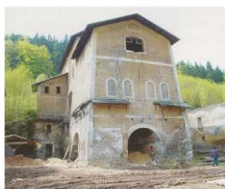
2. ábra A Károly-kohó, épült 1843-ban, ma műemlék
